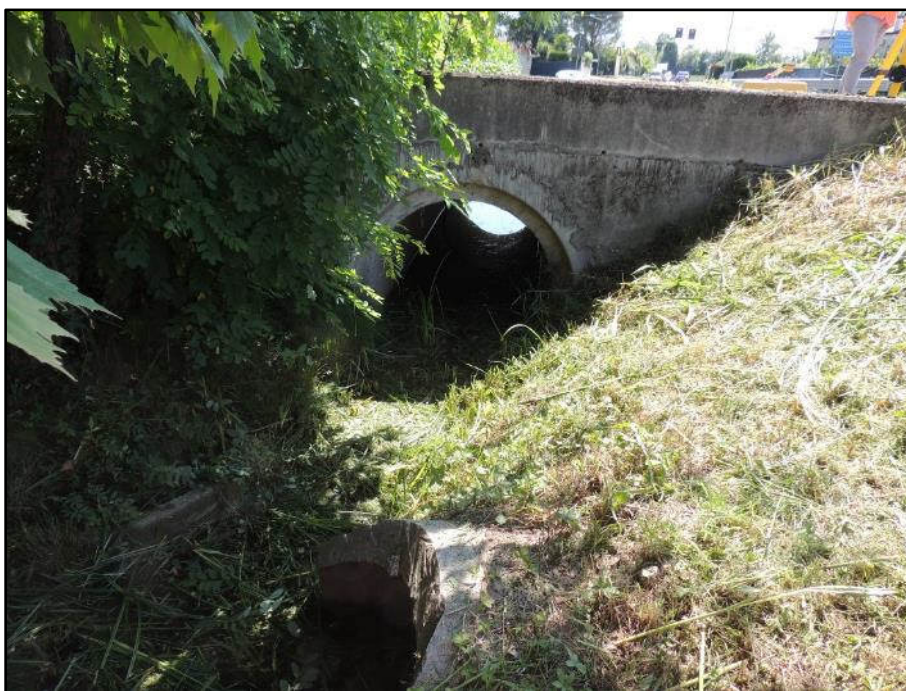
FOTO N.3 – Tratto tombinato, passo carraio, a nord della “S.R. N. 245”
