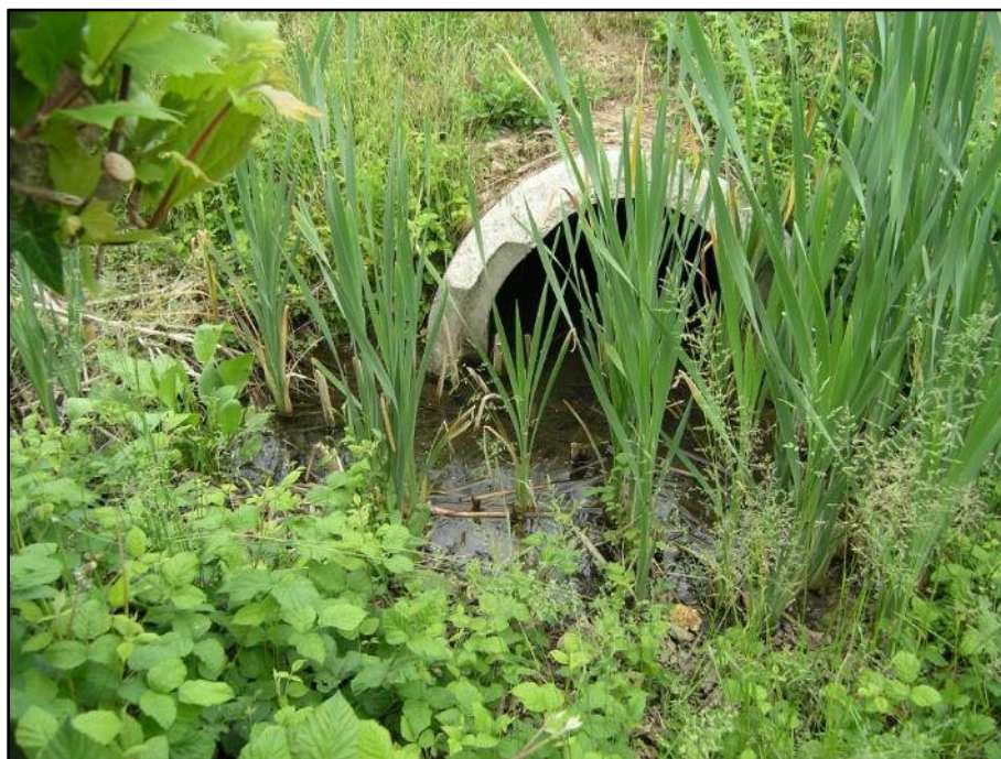
FOTO N. 1 – Ingresso tratto tombinato Ø100, a sud della “S.R. N. 245”
