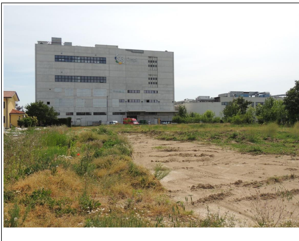
FOTO N. 6 – Vista da Nord-Est
