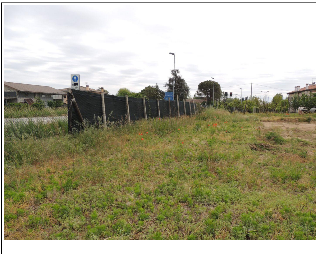
FOTO N. 4 – Recinzione esistente su fronte strada
